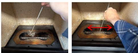
Abbildung 7: Reinigung des Brennergitters
